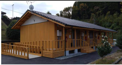
【美里町の応急仮設住宅】
