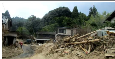
【流木や瓦礫が滞留している様子】
