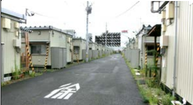
【仙台市内の仮設住宅】
